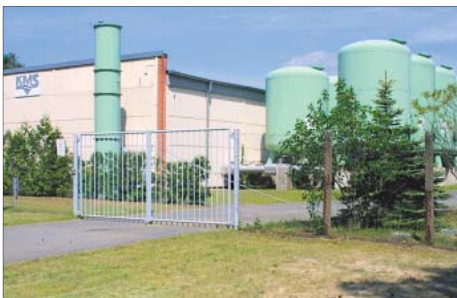
Das größte Wasserwerk des Verbandes: Lindenbrück.
