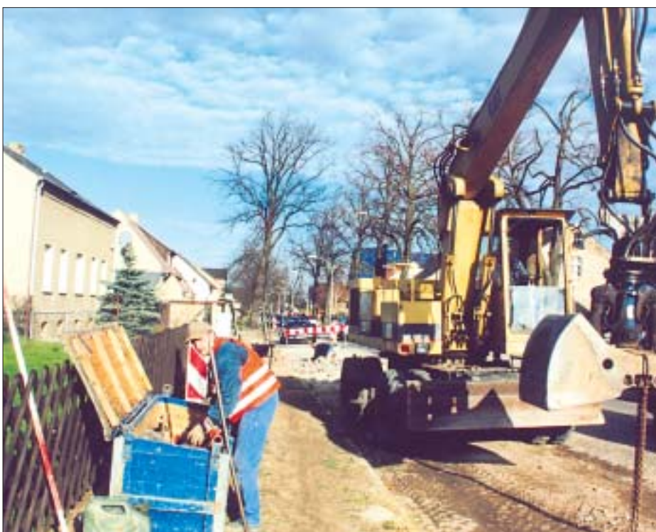
Verlegen von Abwasserrohren in der Blankenfelder Dorfstraße.
