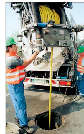
Regelmäßig werden die Abwasserleitungen gespült. Die DNWAB setzt zur Kanalnetzreinigung moderne Technik, wie z. B. dieses Hochdruckspülgerät vom Typ „Elefant 2000“, ein.
