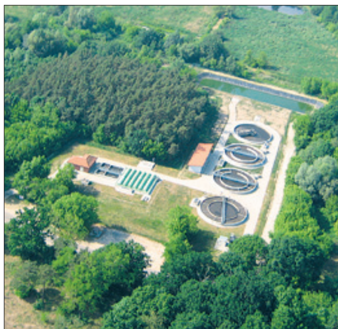
Am Standort Wünsdorf wurde die Anlage für die Klärschlammstabilisierung fertig gestellt.
