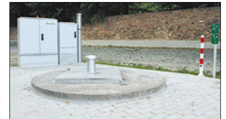
Das Abwasserpumpwerk Grünstraße in Dahme/Mark wurde vom TAZV Luckau in diesem Jahr aufwendig saniert.
