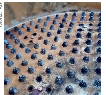
Die defekten Düsen auf dem Filterboden wurden erneuert.
