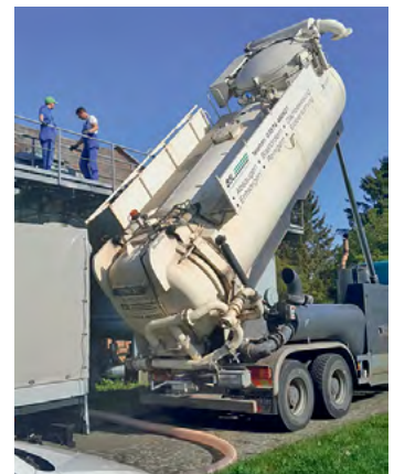
Das Spezialfahrzeug spülte den ausgesaugten Filterkies zurück.
